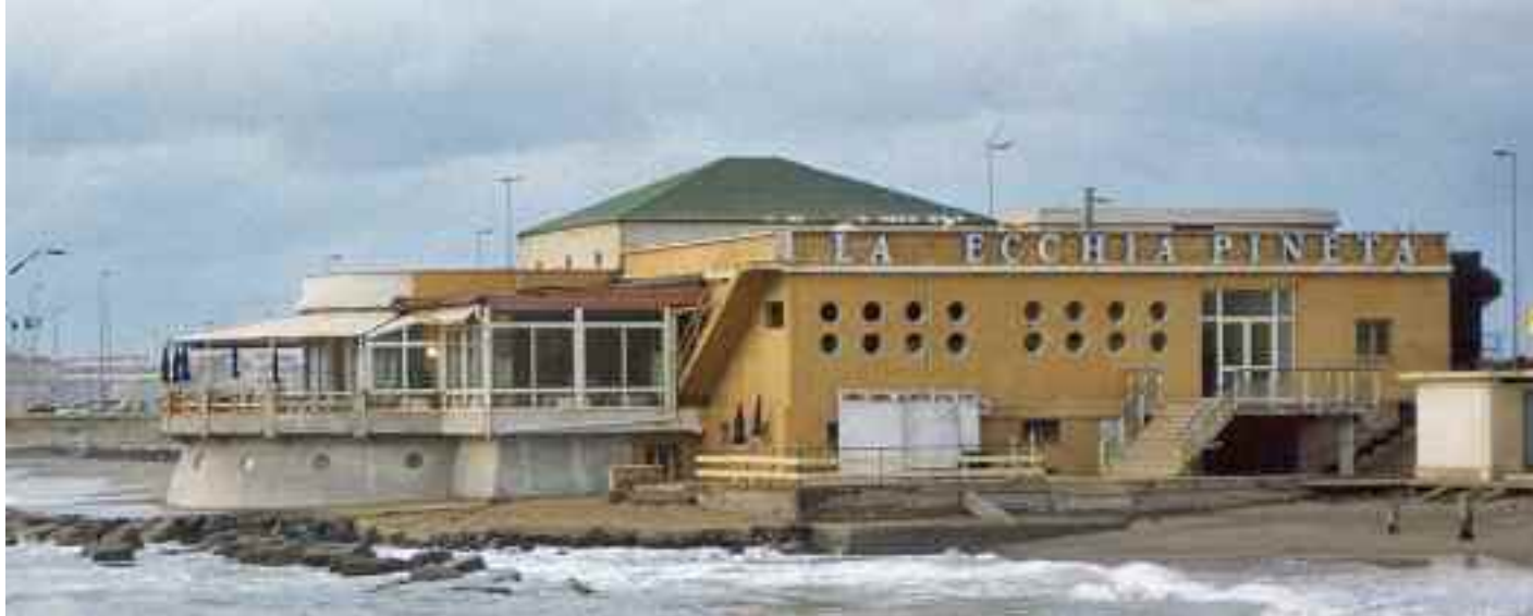
• Un'immagine dello stabilimento prima dell'intervento attuale
